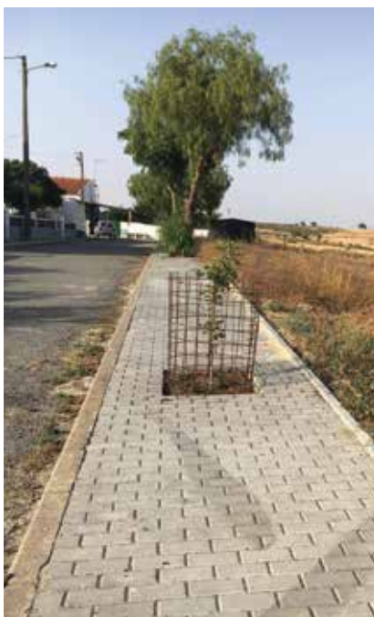
Pavimentação de arruamentos nos Namorados
