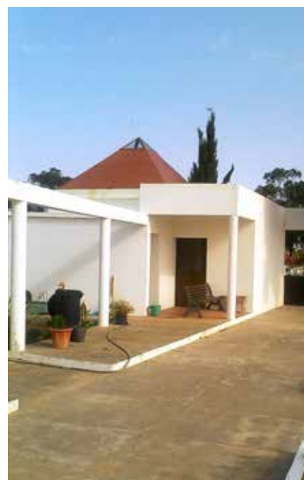
Electrificação das instalações sanitárias e arrumos do cemitério de Casével
